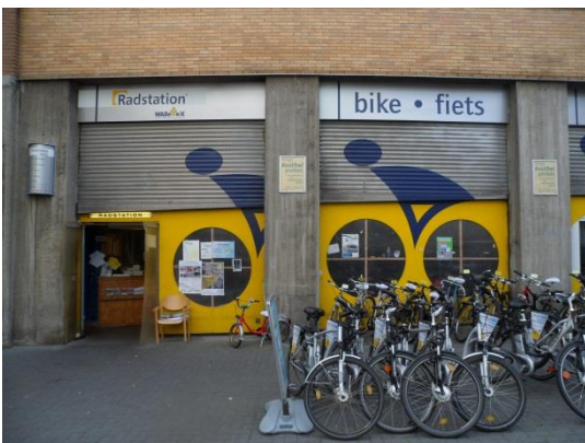
(Außenansicht der Radstation am Aachener Hbf)
