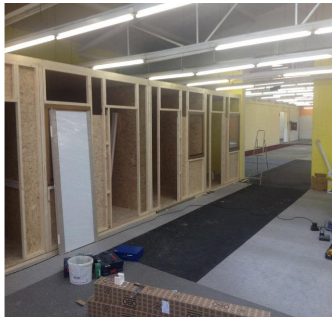
(Letzte Aprilwoche: Büro-, Besprechungs- und Umkleide-räume werden aufgebaut. Noch gibt's viel zu tun)
